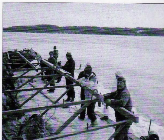
Kallioisiin "syvänlaiturin" runkoasennus etenee.
